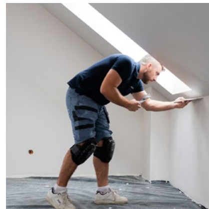
Gładzie na ścianach i sufitach
